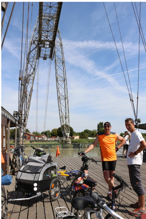
Pont Transbordeur de Rochefort
